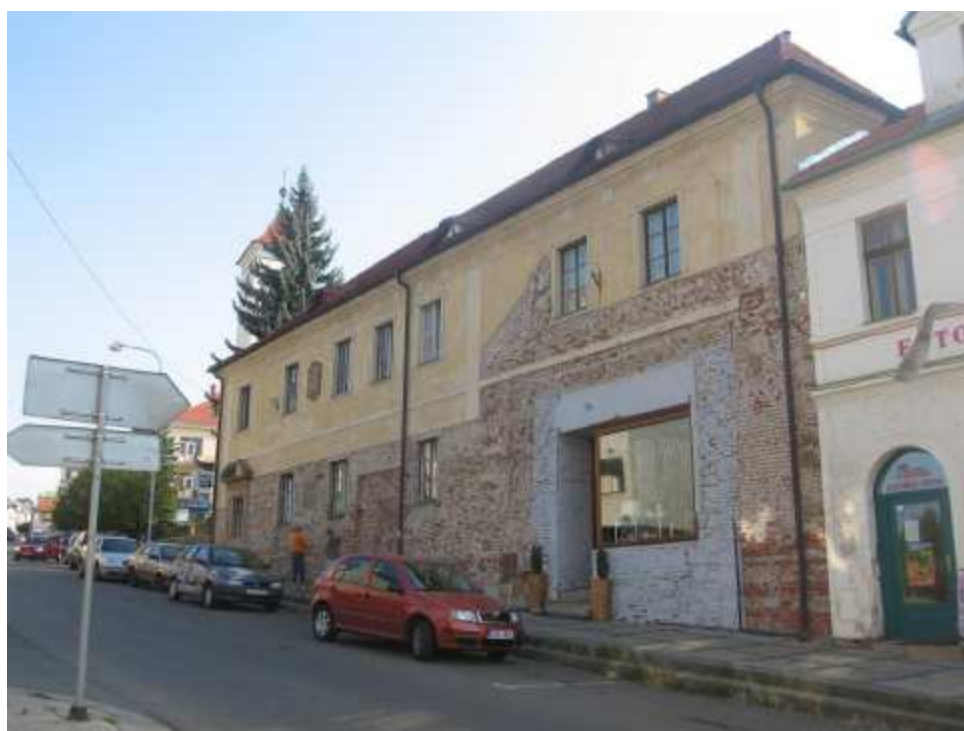
Foto č.3 – čelní fasáda po osekání degradovaných omítek (foto z roku 2007)
